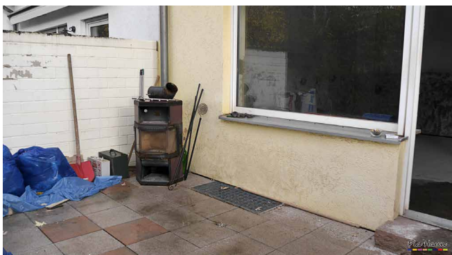
Abb. 6: Reihenhausbebauung mit Gebäudetrennfugen
