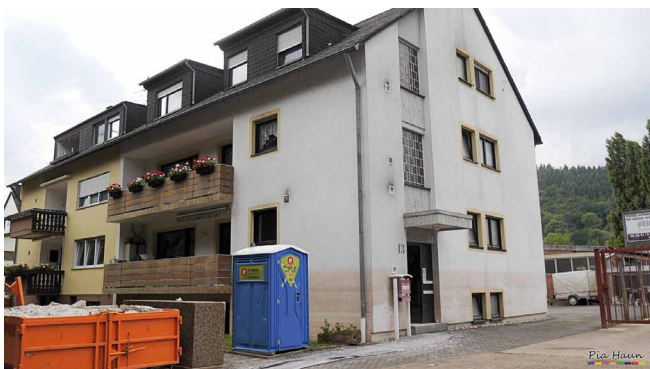
Abb. 8: Kontaminierte Fassade nach Ölschwemmung aus der Nachbarschaft
